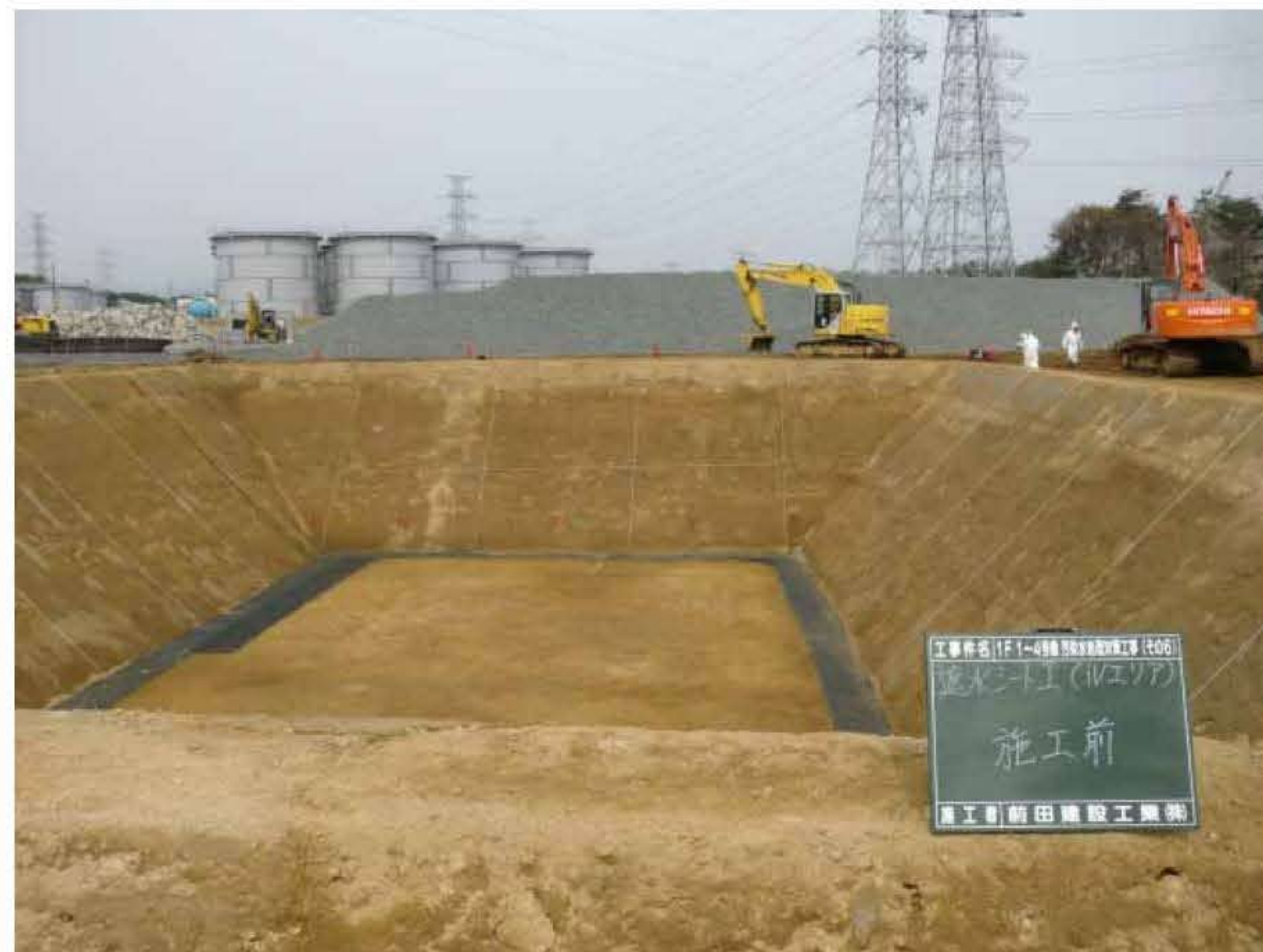
【掘削・地盤改良完了】
