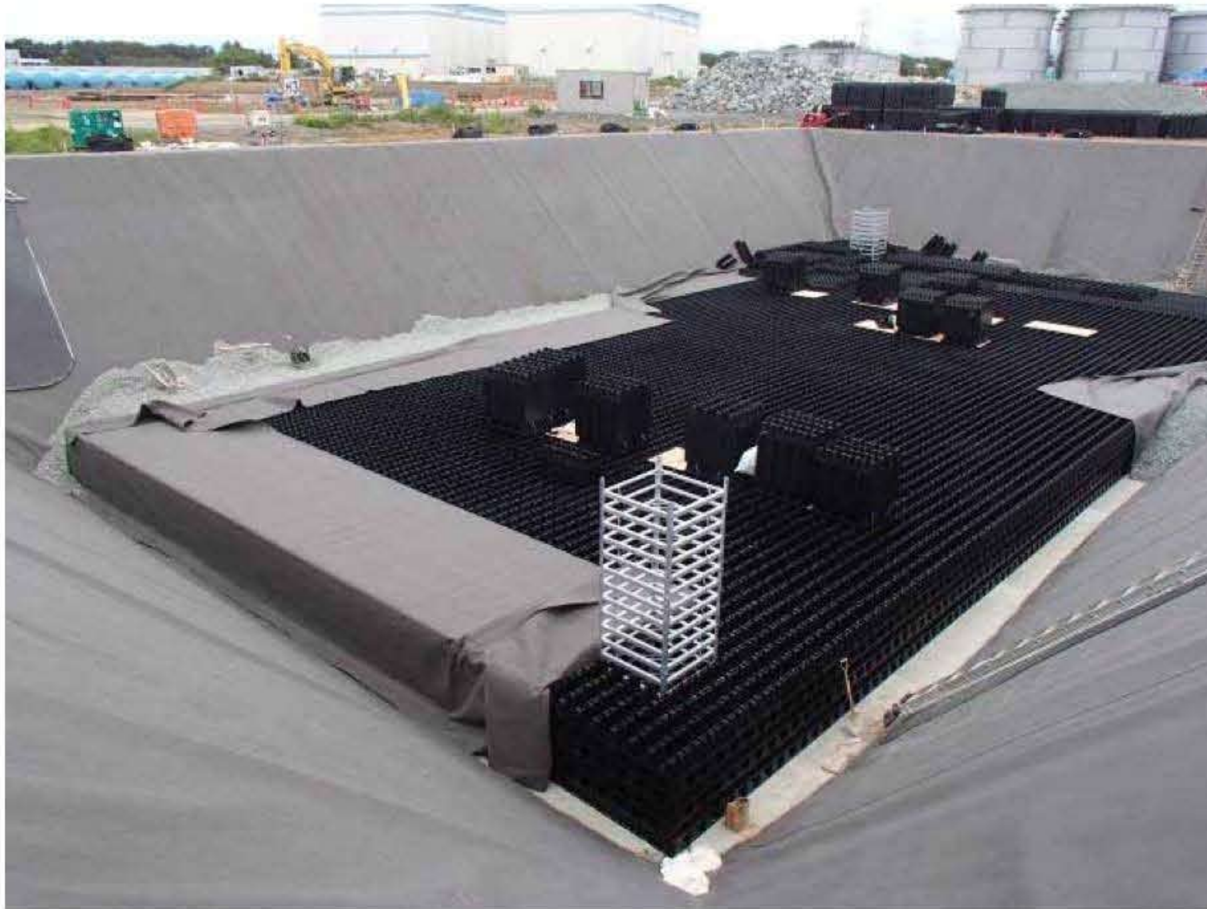
【貯水材組立状況】
