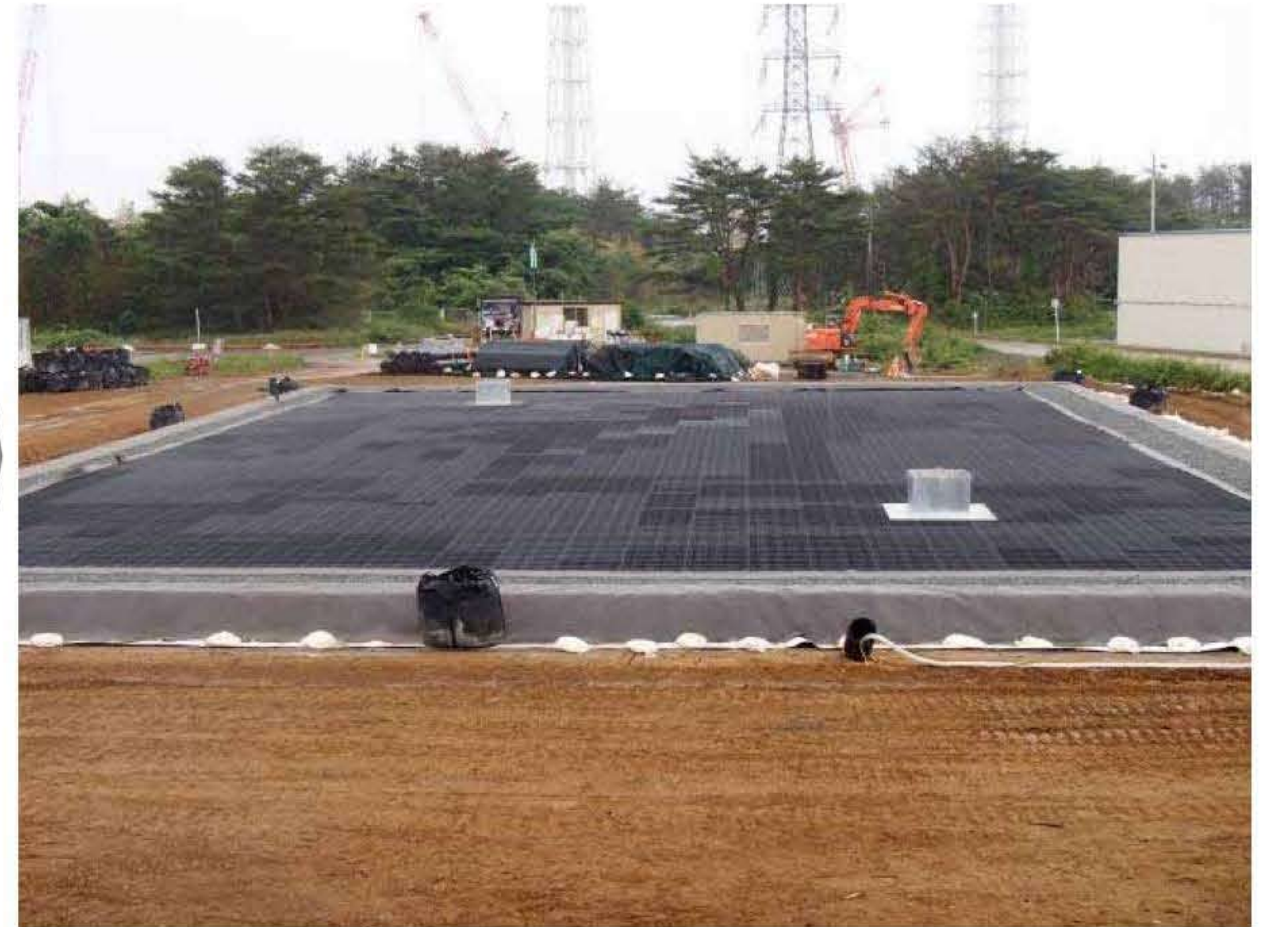
【貯水材組立完了】
