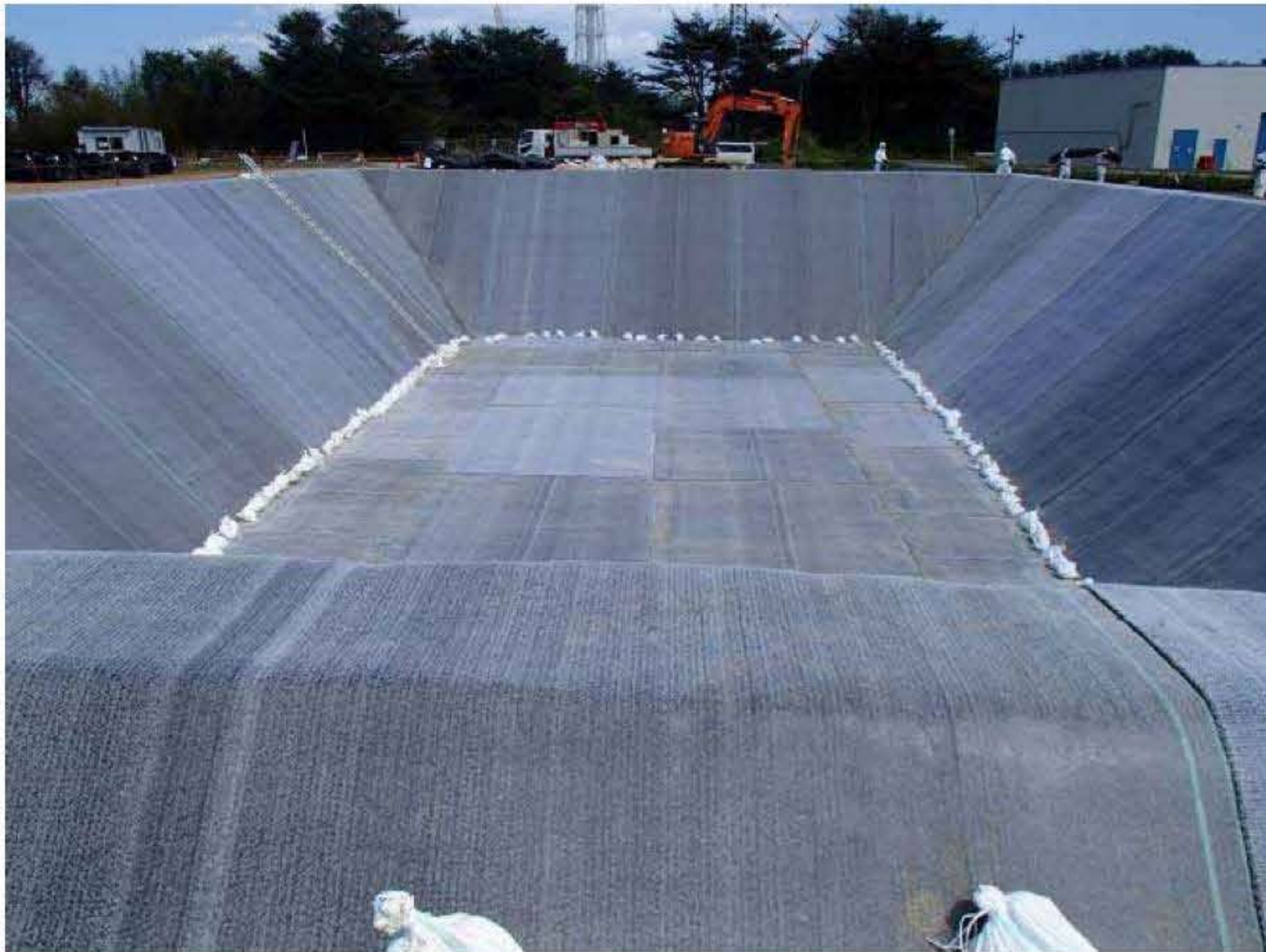
【ベントナイトシート敷設完了】
