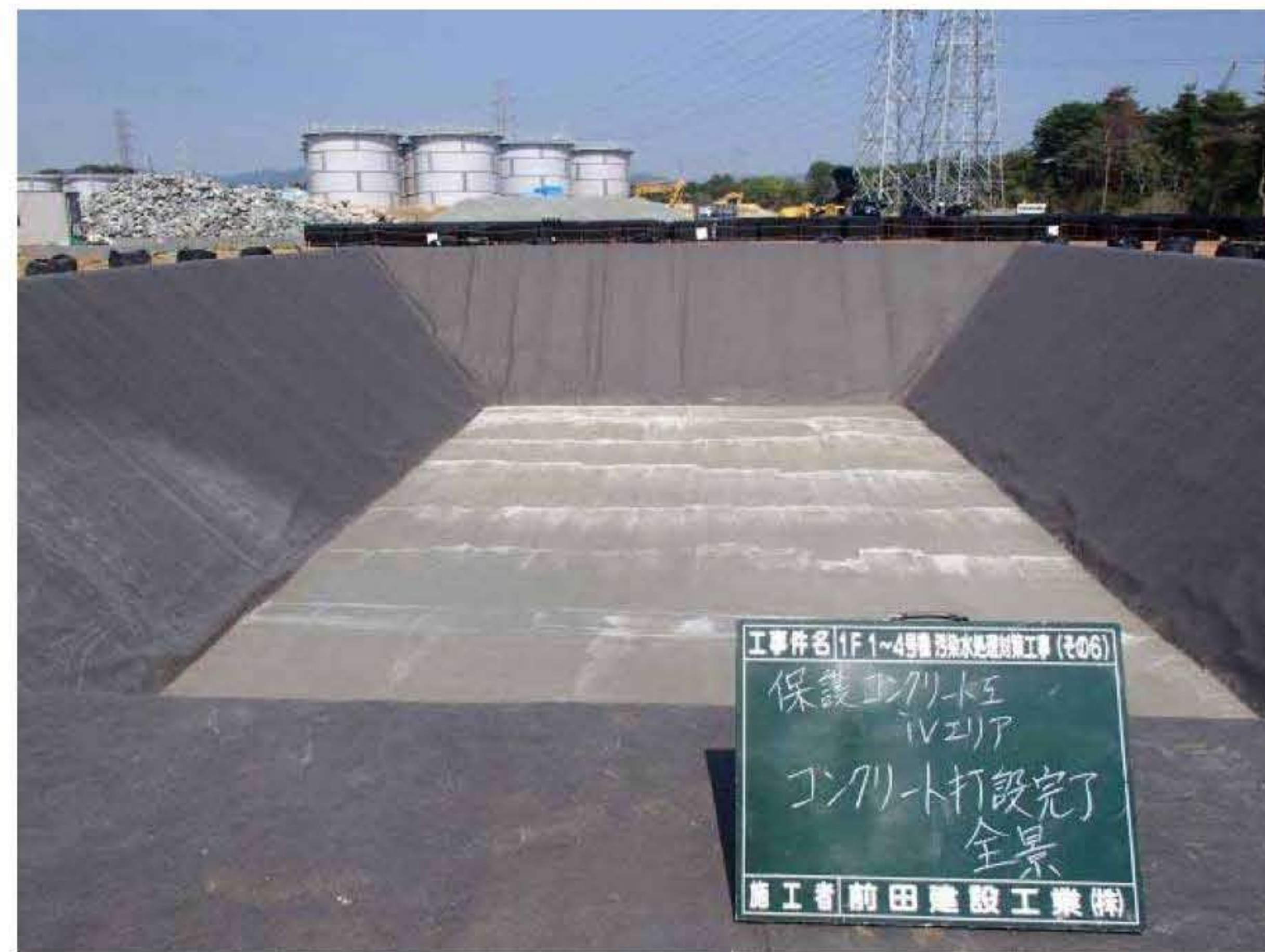
【保護コンクリート打設完了】
